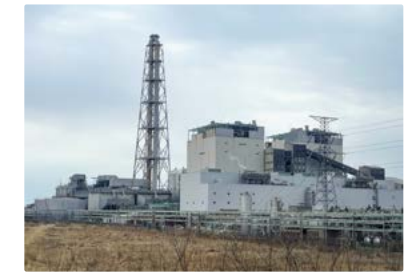
酒田共同火力石炭火力発電所
