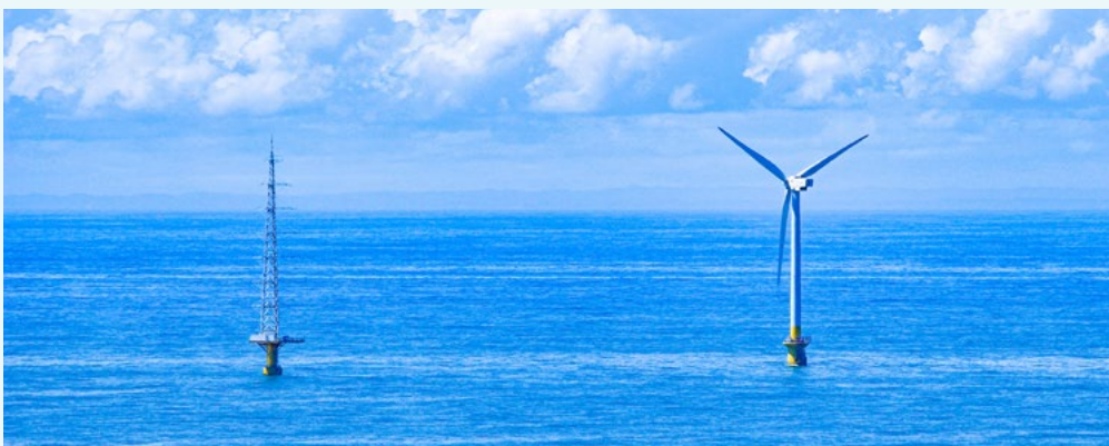
銚子沖洋上風力発電所（千葉県銚子市）
